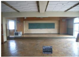
改修前 音楽室
