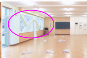
補強後（職員室）
