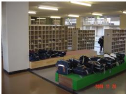
改修前 昇降口
