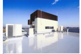
改修後 屋上塔屋
