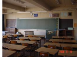
改修前 普通教室
