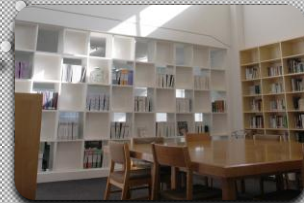
室用途に配慮し、棚兼用の格子鋼板耐震壁による補強(建築学棟図書館閲覧室)
