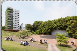
周辺環境と調和するよう壁面を緑化し、生きた教材としても活用(建築学棟)
