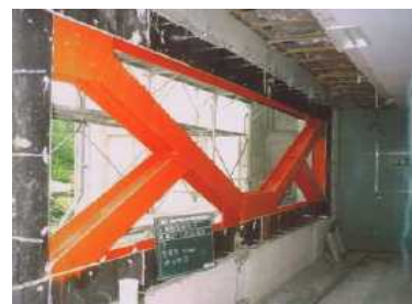
鉄骨ブレースによる耐震補強
