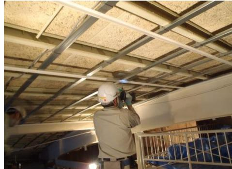
天井ボード止め材の塩ビジョイナーを設置
