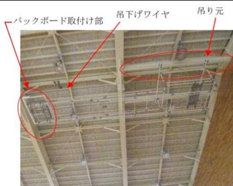
写真○:吊下式バスケットゴールの主な確認ポイント
