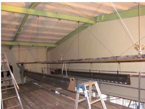
ステージの吊下形ライトにも振れ止めを設置
