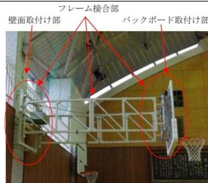
写真○:壁面式バスケットゴールの主な確認ポイント
