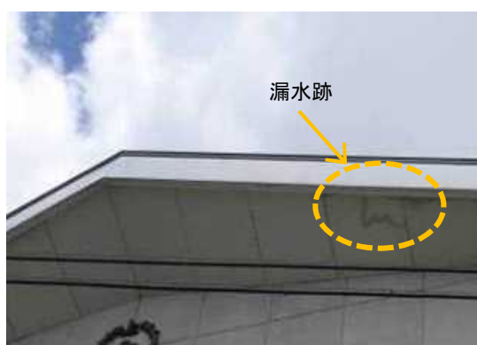
写真 49 軒天井の漏水跡の例
