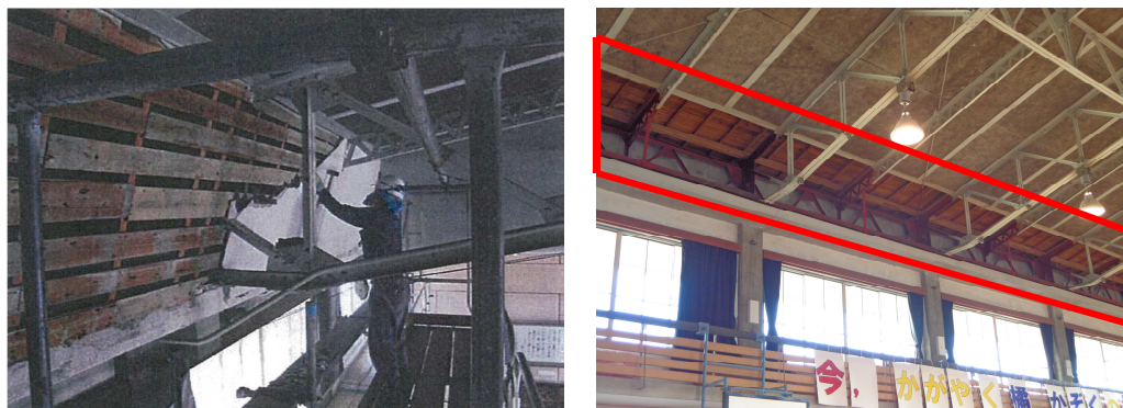
写真 48 既存のモルタル下がり壁を下地から撤去した事例
