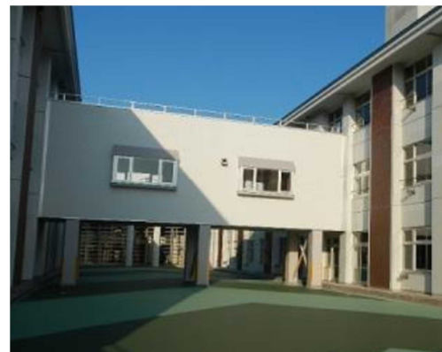
写真 45 地震被害への復旧対策の例
