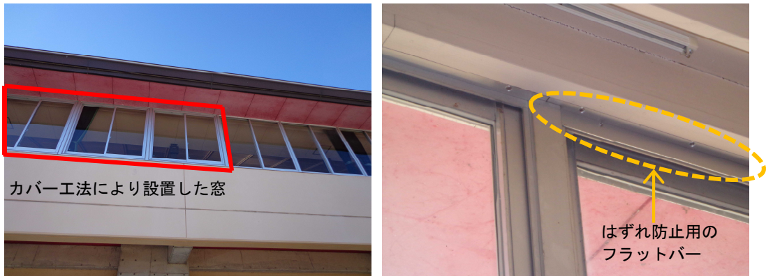
写真 46 カバー工法により既存枠に新設枠を設置し復旧した事例 (枠上部にはずれ防止用のフラットバーも設置)
