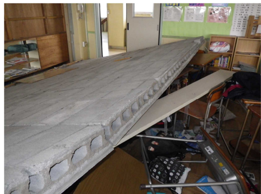
写真23 RC造架構との境界部分
