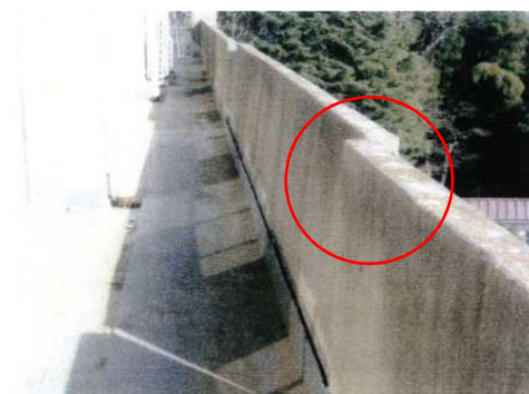
写真21 バルコニー先端の RC 造腰壁の傾斜
