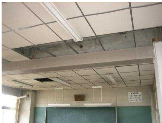
写真 12 システム天井の脱落（普通教室）
