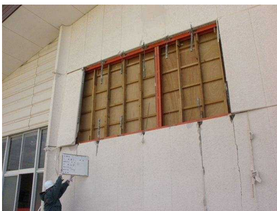
写真 34 妻壁の ALC パネル(縦壁挿入筋構法)の脱落
