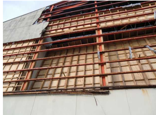
写真 33 取付け部の状態
