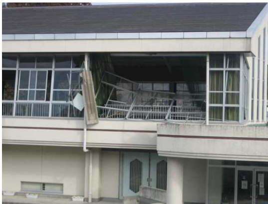
写真 31 横連窓の大規模な脱落・損傷（南面）
