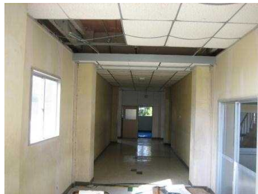
写真 13 Tバーの破損・変形（廊下）
