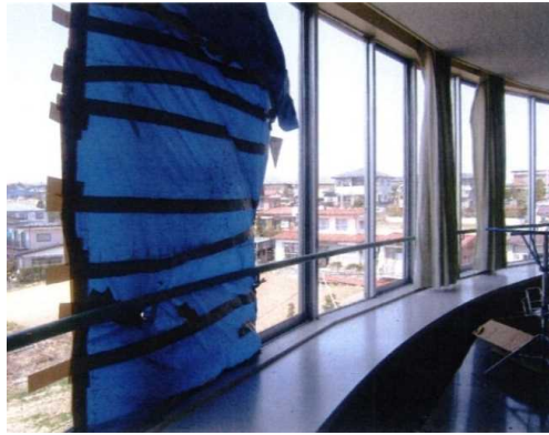
写真15 横連窓の障子ごとの脱落 (4階音楽室)
