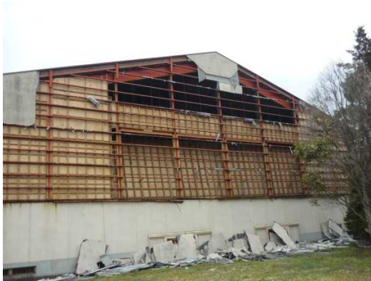
写真 32 外壁妻壁のラスシートの全面脱落
