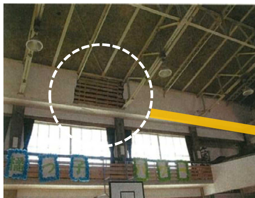
写真 41 内壁モルタルの脱落
