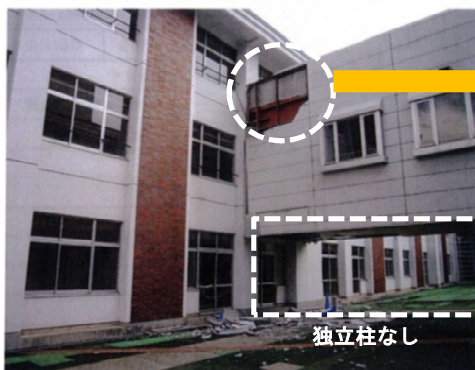
写真17 外装材 (押出成形セメント板) の脱落
