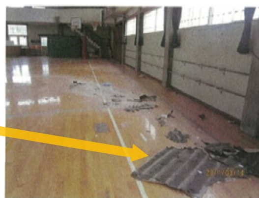
写真 42 脱落したモルタル
