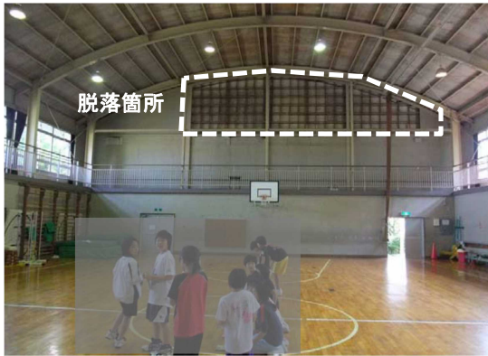
写真 38 妻面内壁(有孔ペニヤ板)の大規模脱落
