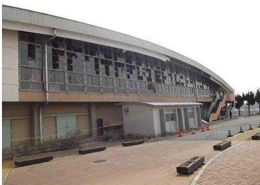
写真 29 桁行面の開口部の被害
