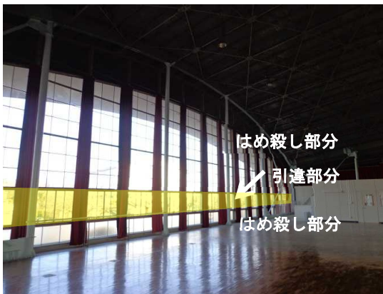
写真 27 妻面の開口部（復旧後）
