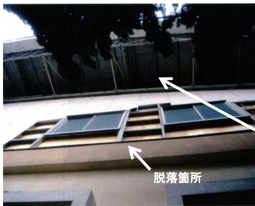
写真 36 外装材（フレキシブルボード等）の脱落
