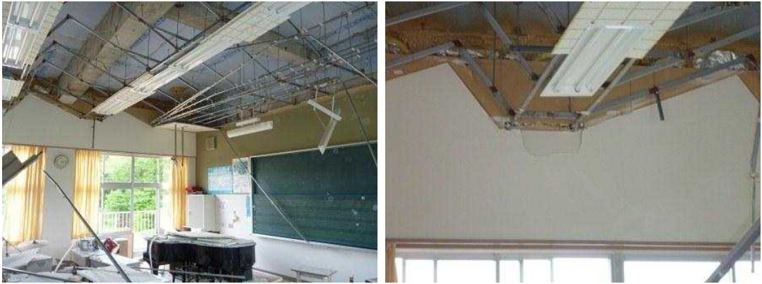
写真 11 段差・折れ曲がり天井の脱落
