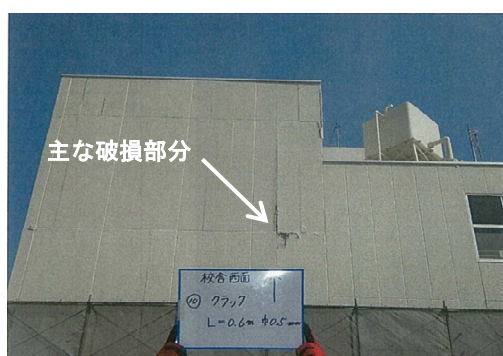
写真19 外装材 (ALC パネル) の損傷
