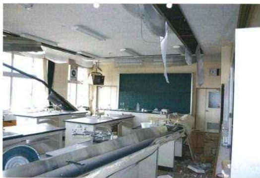
写真 14 天井裏の暖房設備の脱落
