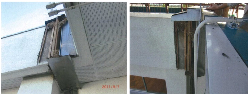
写真26 エキспанション・ジョイントカバーの脱落
