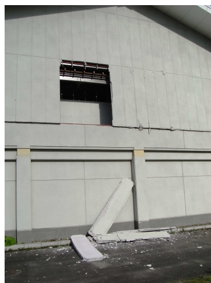
(参考) 写真20 過去の震災における脱落被害
