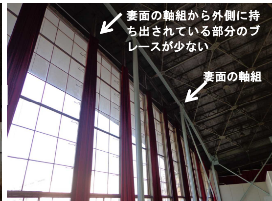
写真 28 妻面の開口部の屋根ブレース
