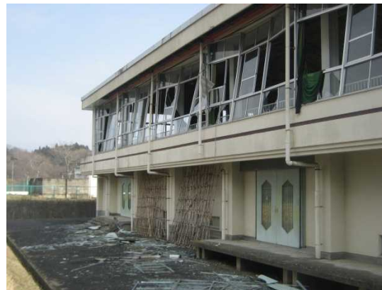
写真 32 横連窓の大規模な脱落・損傷（北面）
