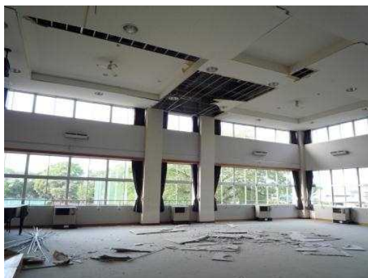
写真10 階高の高い大空間の天井の脱落
