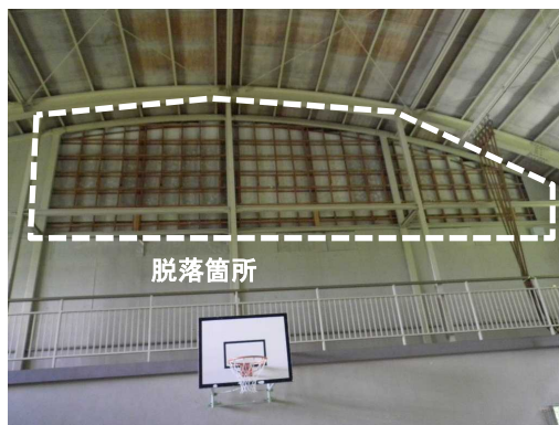
写真 8 内壁（有孔ベニヤ板）の脱落
