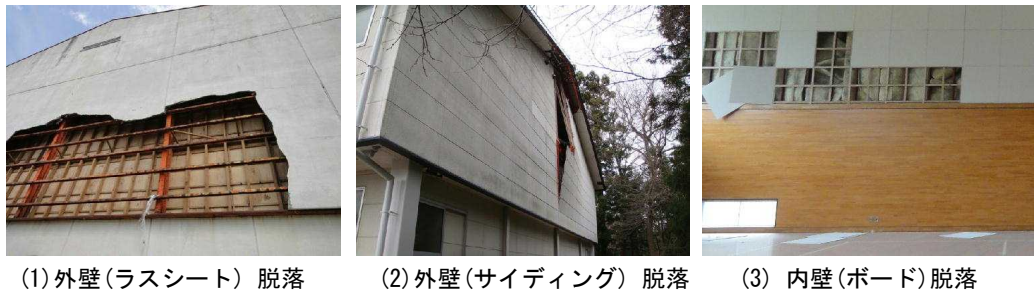
写真 4 外壁・内壁の脱落
