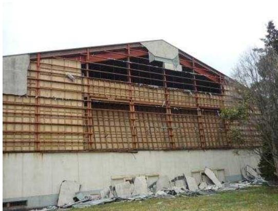
写真 7 外壁妻壁のラスシートの全面脱落
