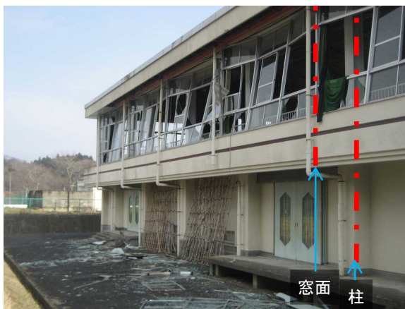
写真 6 桁行面の窓と柱の関係 (例)
