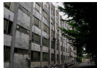
老朽施設の外観(築48年)(東工大)
