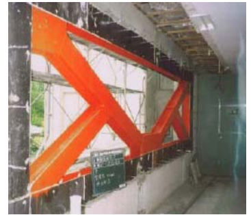
鉄骨ブレースによる耐震補強
