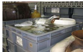
◇漏水による研究試料の水没◇ 空調機(経年30年) —人間文化研究機構—
