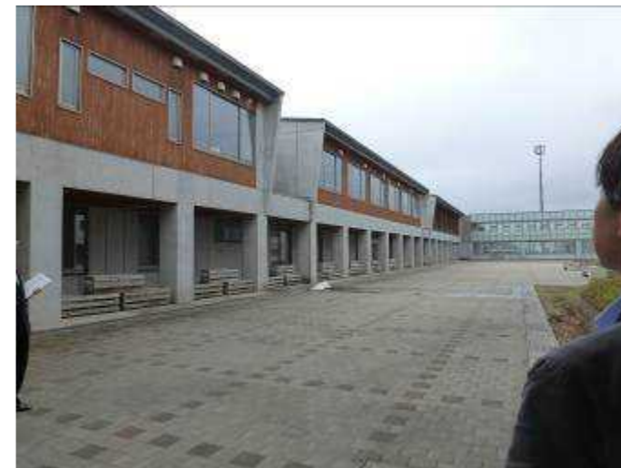
図3 中学・管理棟外観
