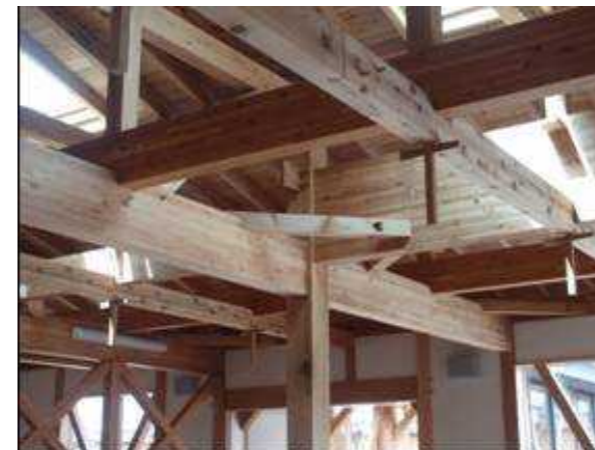
図 4 杉ホール（管理棟） （渡りあごや追っ掛け台栓、雇い実が見られる）
