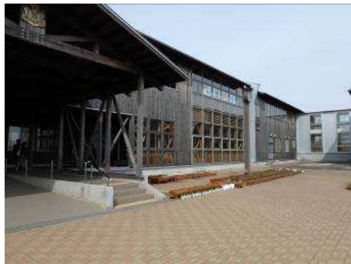
図 1 外観（中央奥に防火壁）
