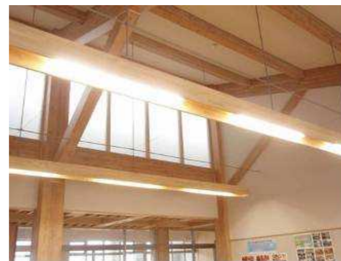
図4 多目的スペース上部（中学・管理棟）
