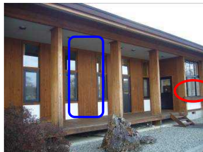
図4 大断面の大型集成材パネルの構造壁（青囲み）
