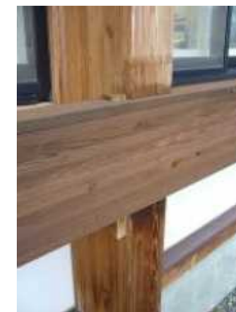
図5 中ガラミ工法 （図4 赤囲み部分）
