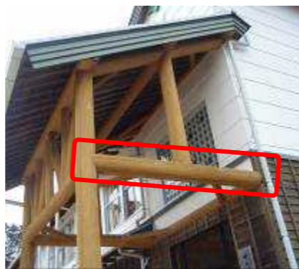
図2 腐食交換した横架材
