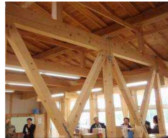
図 3 露出の木筋交による耐力壁（図書室）
