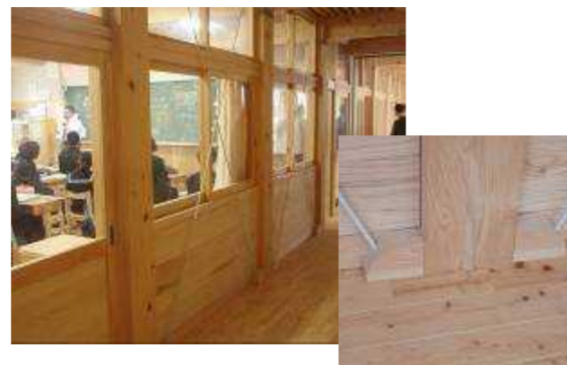
図 2 廊下丸鋼プレースと脚下納まり
