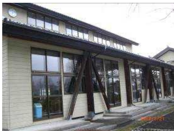
図1 校舎外観（普通教室部分）
