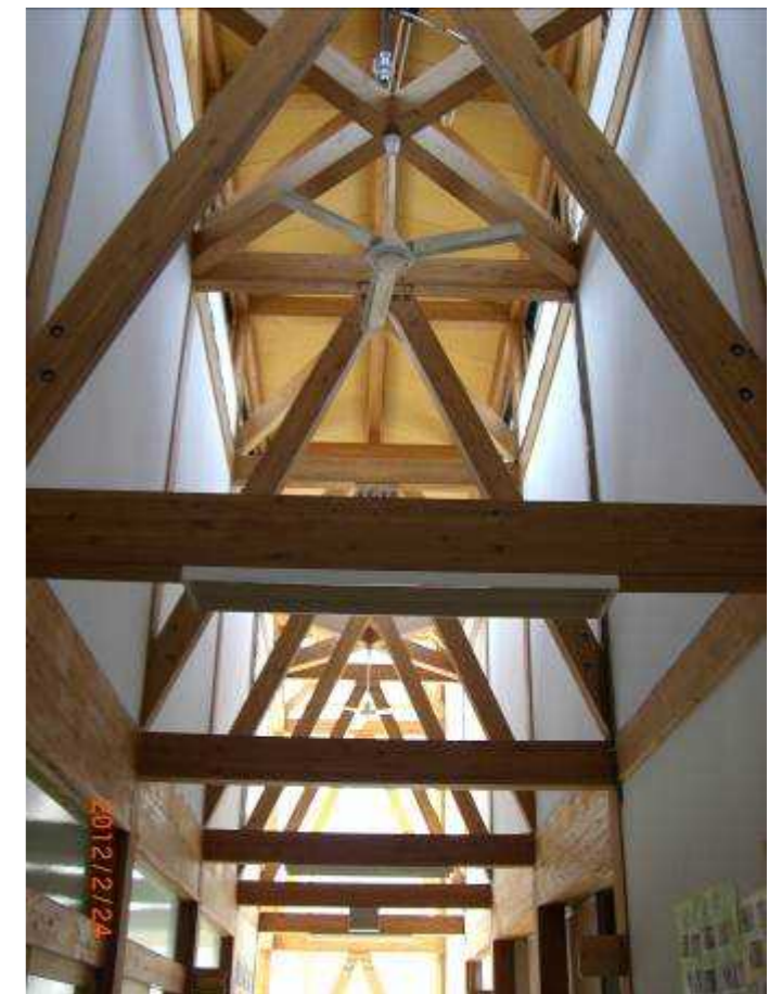
図5 普通教室前の廊下上部
