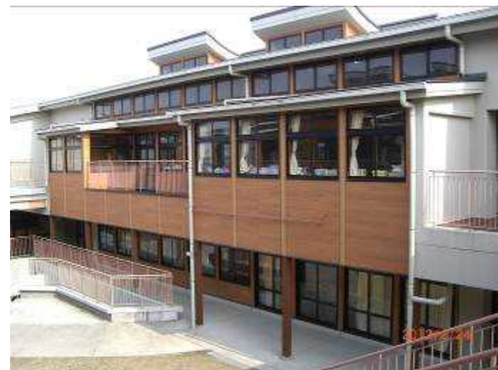
図1 木造部分の外観
