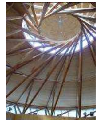
図 6 多目的ホール屋根架構
