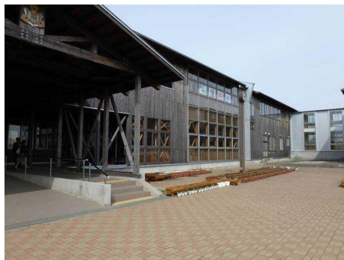
図 1 外観（中央奥に防火壁）
