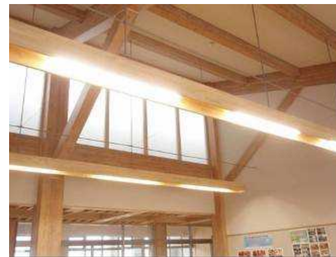
図 4 多目的スペース上部（中学・管理棟）
