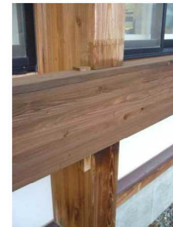
図5 中ガラミ工法 （図4赤囲み部分）
