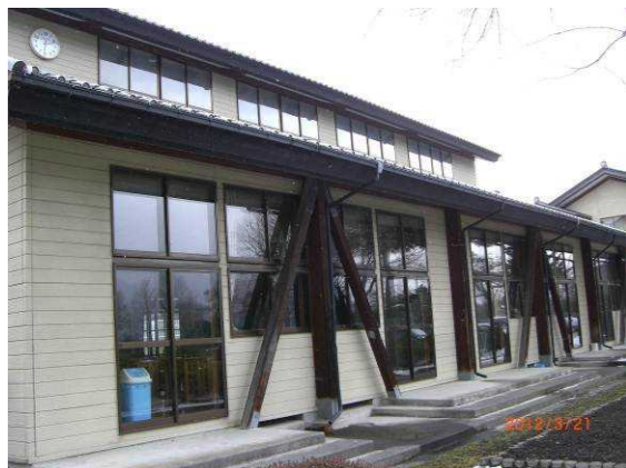
図1 校舎外観（普通教室部分）
