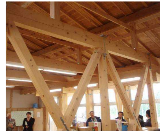
図3 露出の木筋交による耐力壁（図書室）
