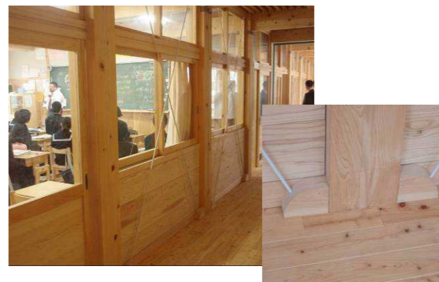
図2 廊下丸鋼ブレースと脚下納まり
