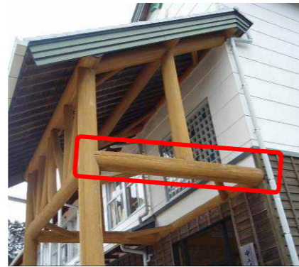
図2 腐食交換した横架材
