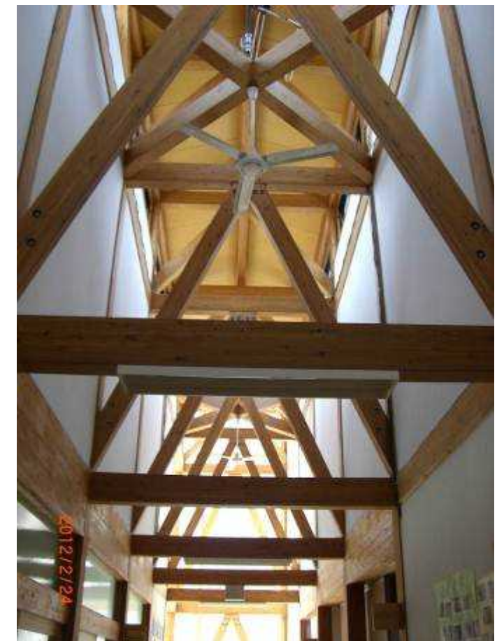
図 5 普通教室前の廊下上部
