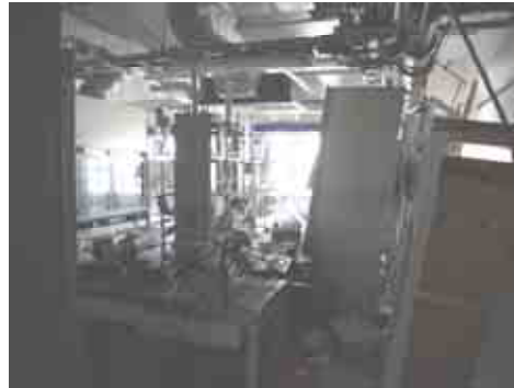
東北大学（実験機器等の破損）
