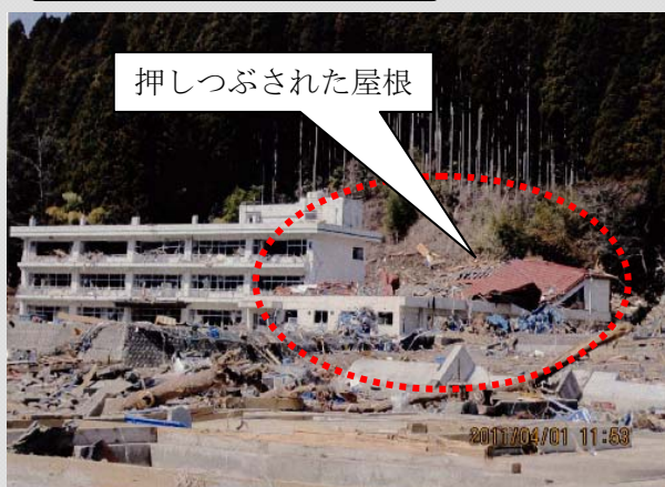
大破した屋内運動場
