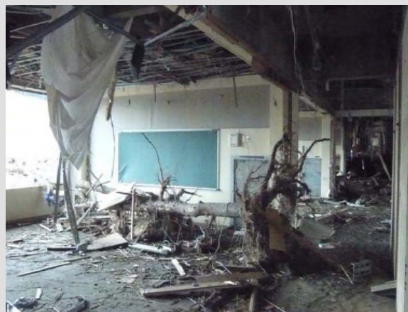
水圧による壁の移動
