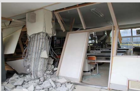
柱や壁の崩壊(旧耐震基準で建築された学校施設)
