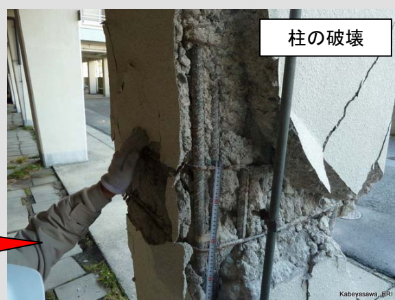
耐震補強済の部分と未補強の部分との被害状況の比較 (未補強部分は翌年耐震補強工事を実施する予定であった)
