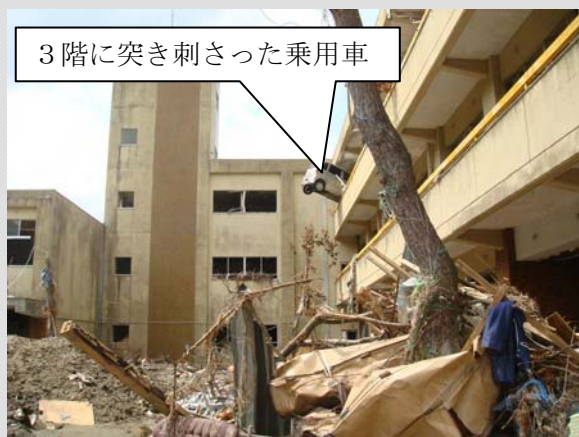
3階まで津波にのまれた校舎
