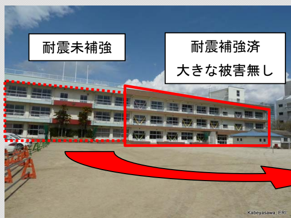
耐震補強済の部分と未補強の部分との被害状況の比較 (未補強部分は翌年耐震補強工事を実施する予定であった)
