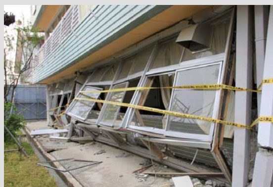
柱や壁の崩壊(旧耐震基準で建築された学校施設)
