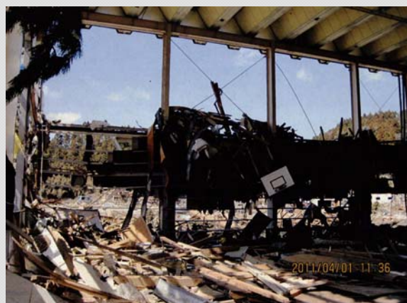
鉄骨の骨組みだけが残った屋内運動場
