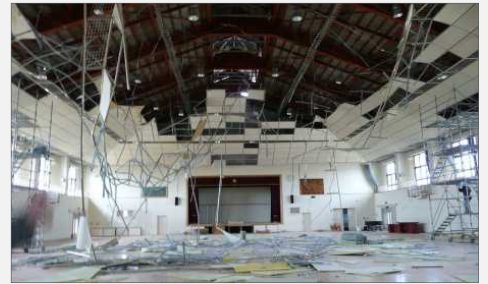
天井材が全面的に脱落した例
