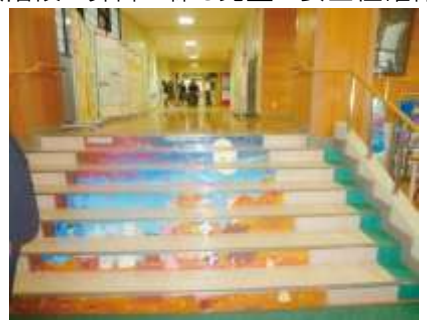
東山泉小中学校(東学舎) 「既存の中学校校舎の階段段差の改善」
