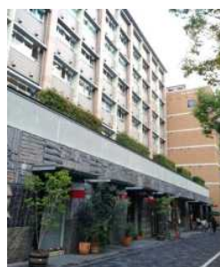
大通りに面した部分に商業施設を配置 (京都市立京都御池中学校)
