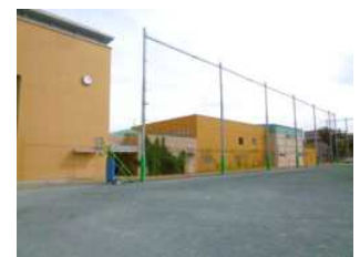
防球ネットと、その奥にある新BOPの入口
