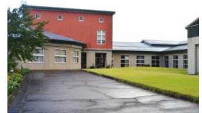
地域交流棟の入口
