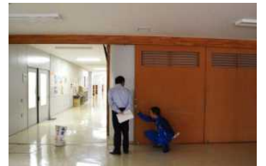
開放部分を仕切るための扉
