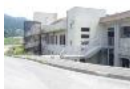
校舎2階と市道をつなぐ非常用通路
