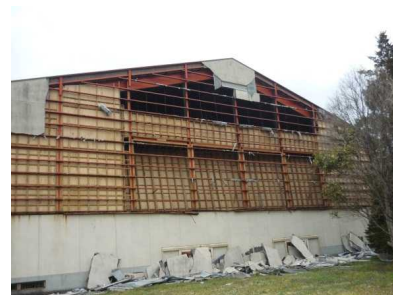
ラスモルタルの脱落
