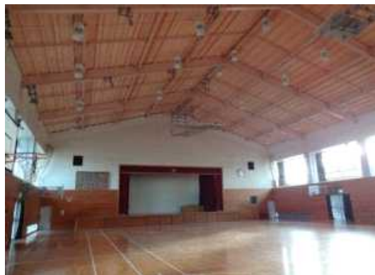
天井撤去後の屋内運動場（対策後）
