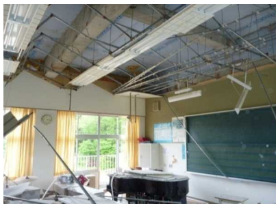
段差・折れ曲がり天井の脱落
