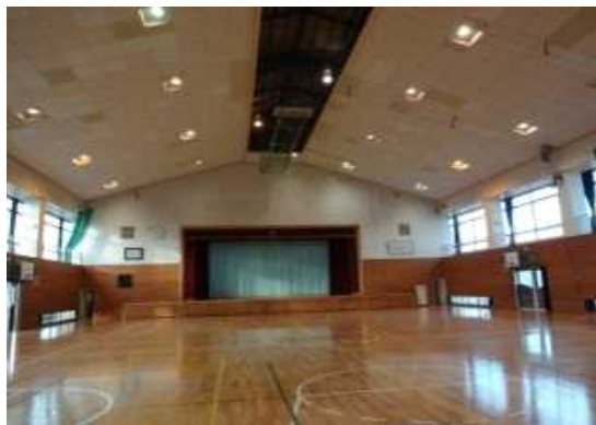
天井撤去前の屋内運動場（対策前）
