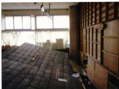
コンクリートブロック壁の崩落
