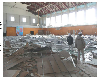
天井材が落下した被害
