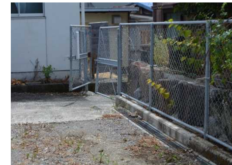
新設した門扉
