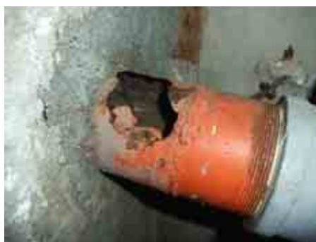
劣化による配管の破損
