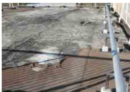
屋上劣化で頻発する雨漏り
