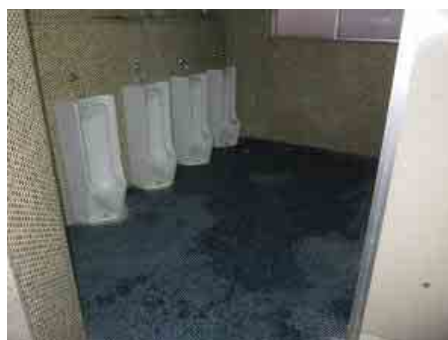
トイレの老朽化による臭気
