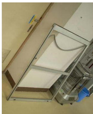
落下した障子
