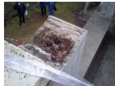
手すりの接合部 （支持部）
