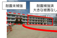
耐震補強済の部分と未保強の部分との被害状況の比較
