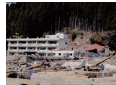
津波による被害
