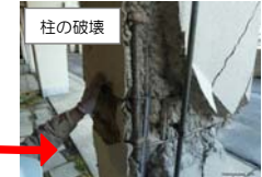
耐震補強済の部分と未保強の部分との被害状況の比較
