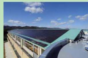
太陽光発電設備の設置
