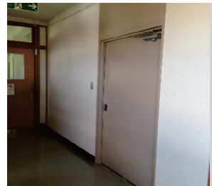
階段前に扉を設置し施設を分離
