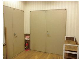
施設内の連絡扉
