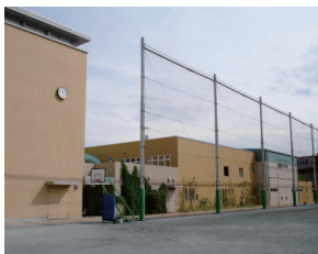
新 BOP 室の入口は校庭側に設けられている
