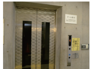
プール専用のエレベーター
