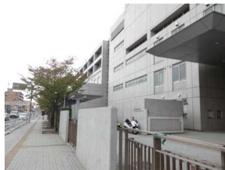
5施設を一体的に整備した 大規模な複合施設
