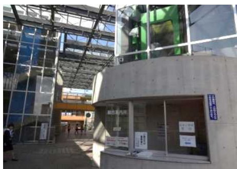
259 小学校のテラスと図書館の入口が 260 近接する2階には警備員が常駐 261 (志木市立志木小学校)
