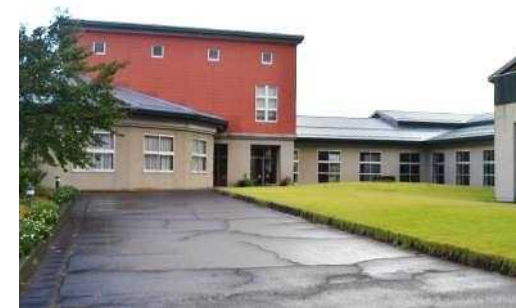
地域交流棟の入口
