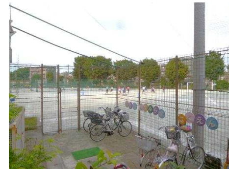
中学校校庭との境界に防球ネットを整備
