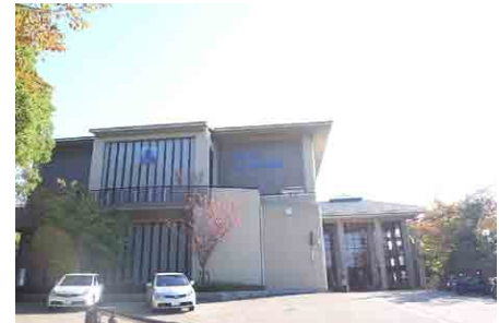
東学舎（セカンドステージ）：月輪中を増築・改修
