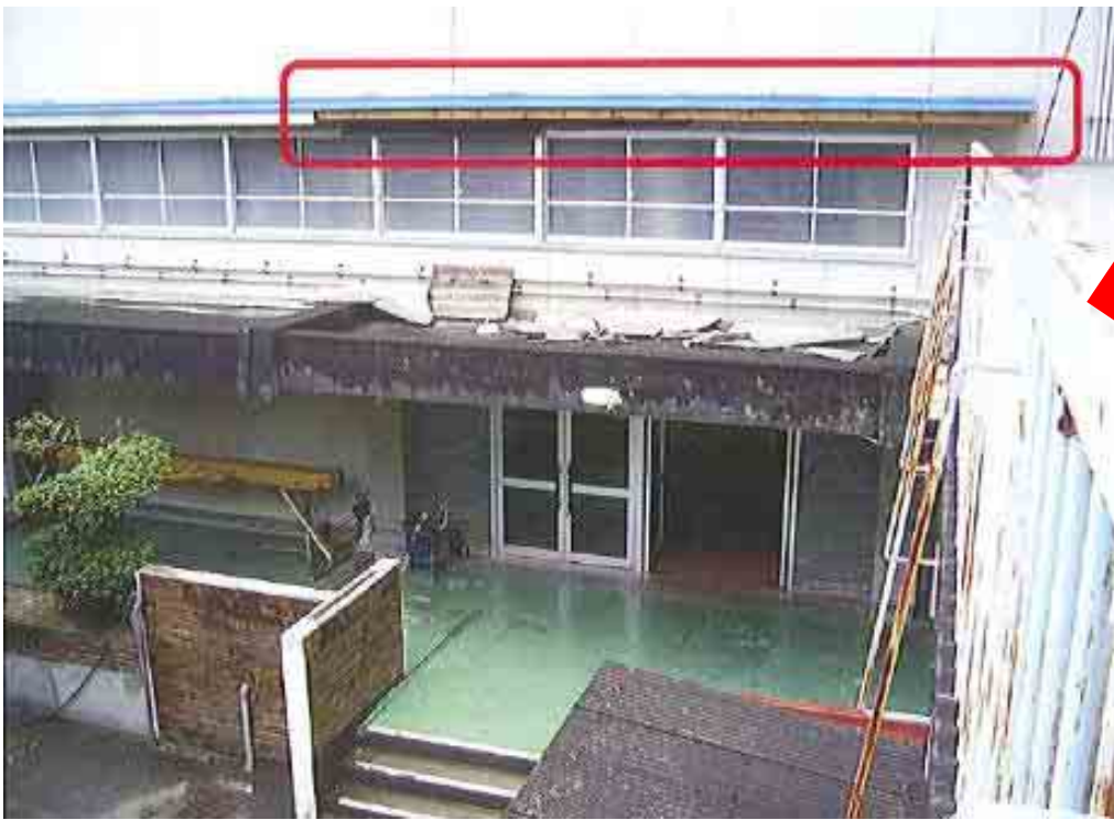
屋内運動場の軒下部分のモルタル片が落下(築44年)
