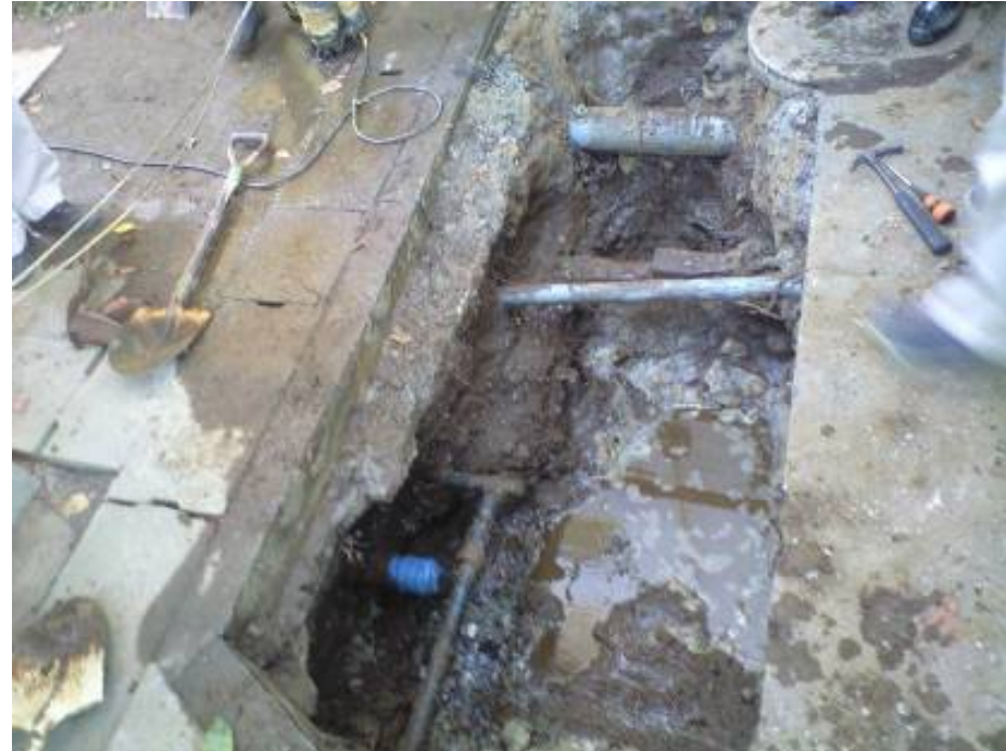
屋外の消火管の破裂。消火栓が使用で きなくなり、一時的に消火器で対応
