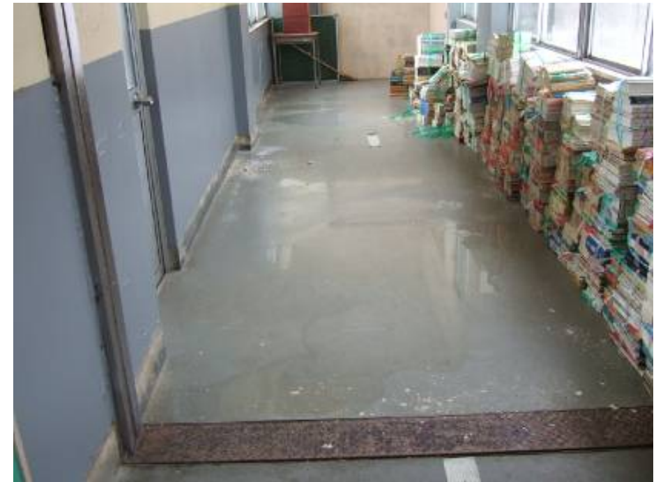
雨漏りにより水浸しになった床(築38年)
