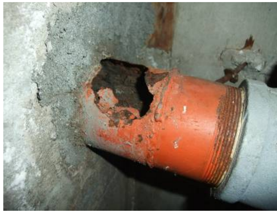
天井裏の雨水排水管が錆びて穴 が空き、雨漏りが発生(築30年)
