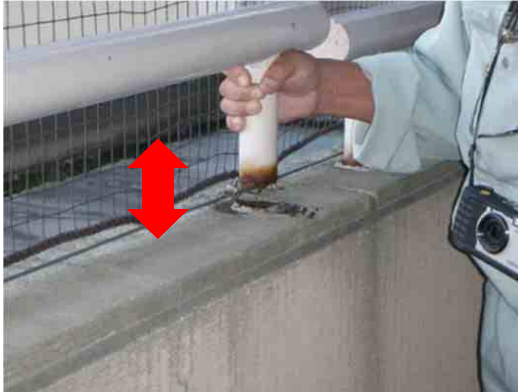
腐食の進んだ手摺が、多数の児童 が一斉にぶらさがった際に破損
