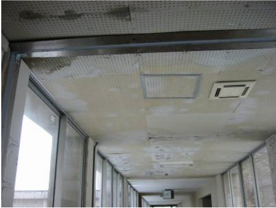
雨漏りにより天井が劣化(築31年)
