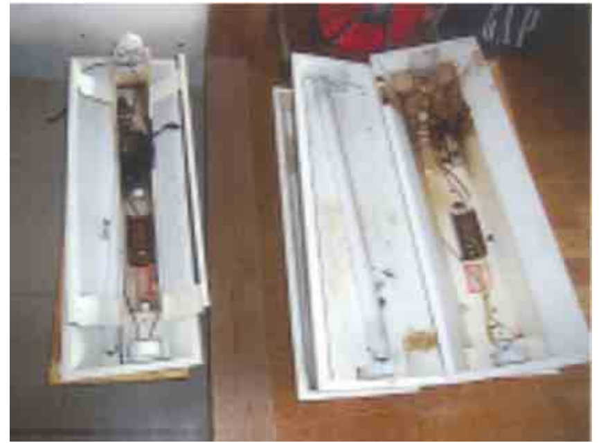
照明安定器が破裂(築41年)
