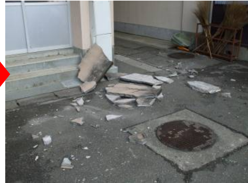
モルタル片が落下(築31年)
