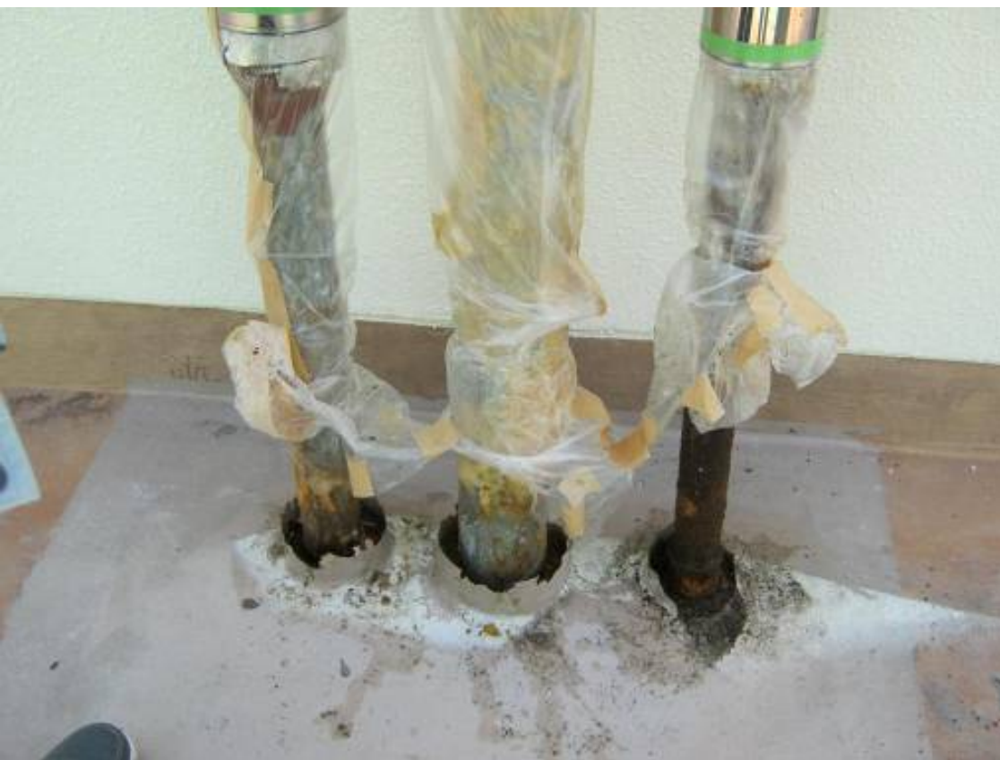
雨水の浸食により消防用鋼管が腐食 (築38年)
