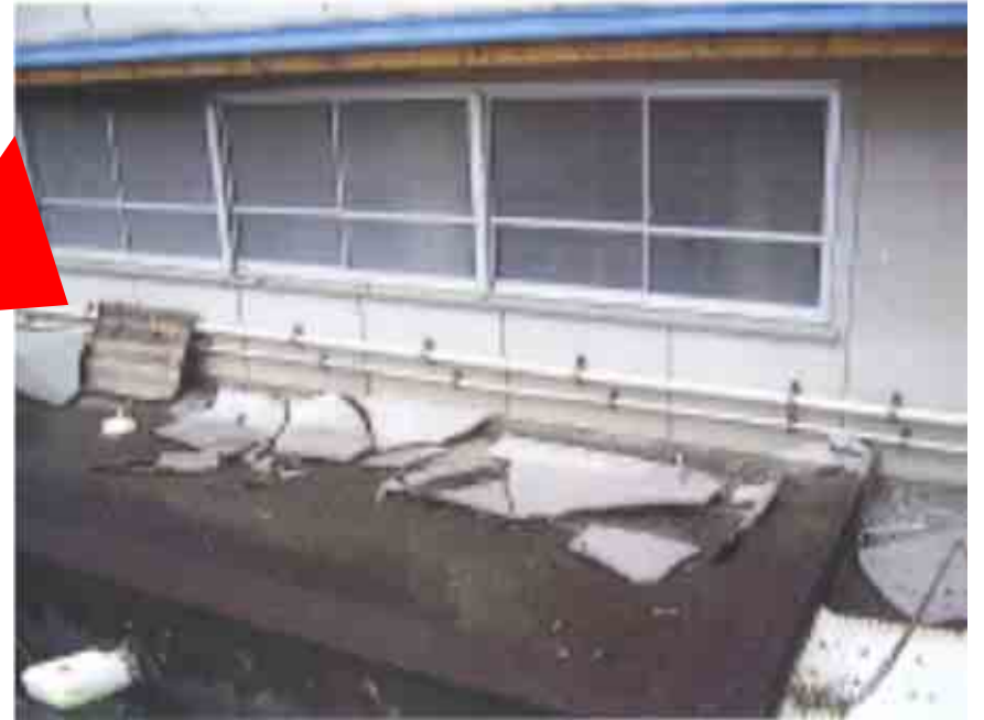
屋内運動場の軒下部分のモルタル片が落下(築44年)
