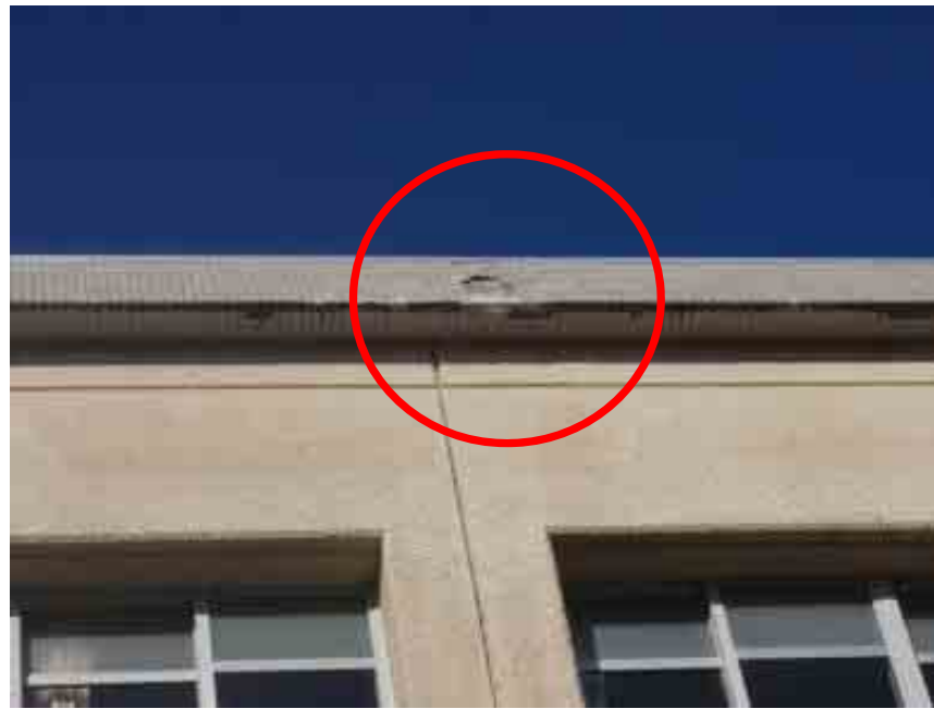
屋内運動場の軒下部分のモルタル片が落下(築44年)
