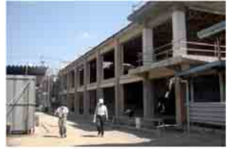
図4 改修中の風景
