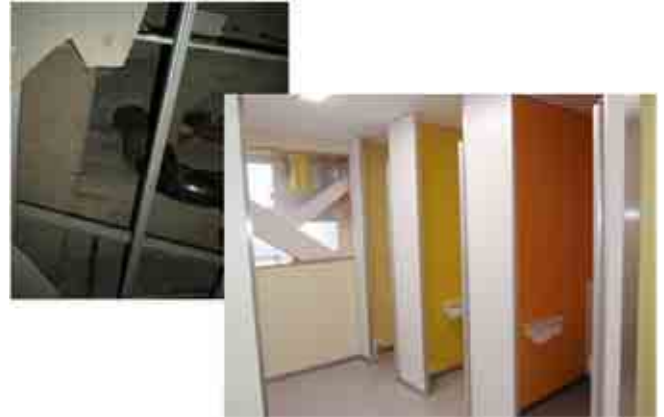
図2 劣化保全整備（トイレ）（左：補修前 右：補修後）
