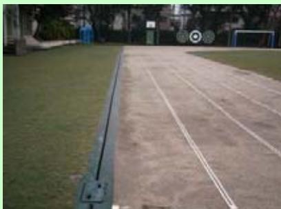
水はけ向上と芝生の侵食防止のため、芝生とトラックの間にスリット側溝を設置(蓮根二小)
