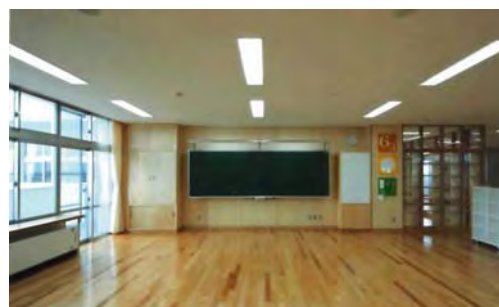
夜間電力を利用した蓄熱暖房機を設置し、今までファンヒーターで使用していた灯油の年間使用量が、11,000ℓ相当分(金額換算で748,000円分)節約できている。なお、灯油の削減の分、電気代が高くなるが、設置目的は、二酸化炭素の排出量の削減である。 (富山県富山市立豊田小学校)
