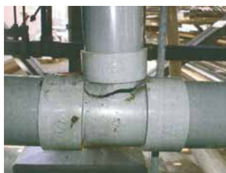
筑波大学（排水管の破損）
