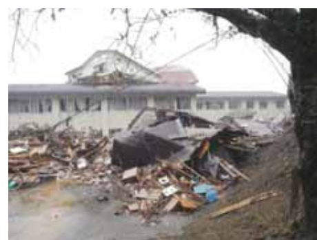
東北大学（建物の流出）
