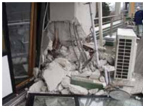
東北大学（柱の崩壊）
