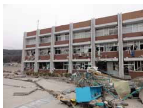
東京大学（津波による建物等の損壊）
