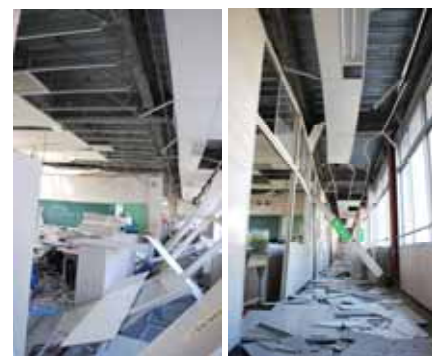
茨城大学（内装材の崩落）
