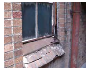
安全性や省エネ性能の著しく低い老朽施設
