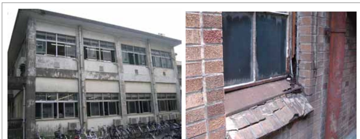
安全面に関わる問題 耐震性が確保されていない老朽施設や、今にも外壁等が落下しそうな老朽施設など、安全上問題のある危険な建物が数多く存在している。
