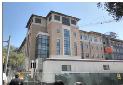
最先端の研究棟の外観
