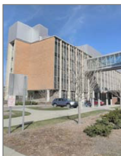
バイオメディカル棟の外観
