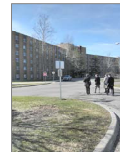
寄宿舎の外観
