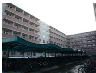
改修後の学生宿舎
