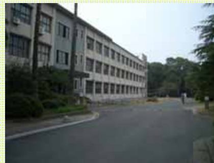
老朽化した施設
