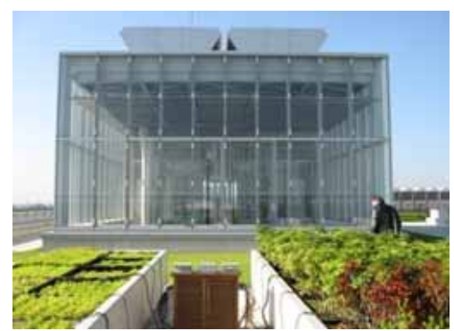
吹抜け上部から屋上へ空気を放出して自然換気
