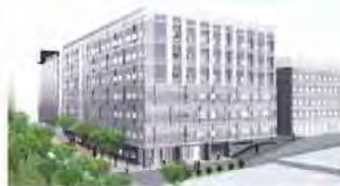
理・農総合研究棟 北棟
