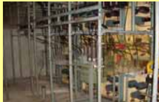
老朽化した受変電設備
