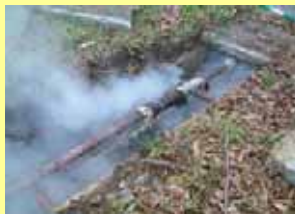
屋外蒸気管の漏れ
