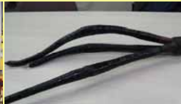
経年劣化により漏電したケーブル
