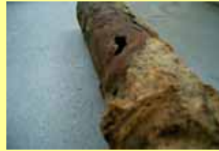
ガス配管の腐食
