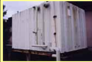
劣化した受水槽
