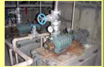
老朽化したポンプ
