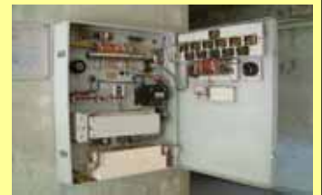
老朽化した自動火災報知器
