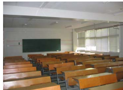
総合校舎D号館 改修前(Is=0.37)
