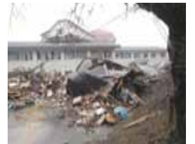
東北大学(建物の損壊)
