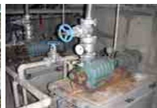
老朽化したポンプ
